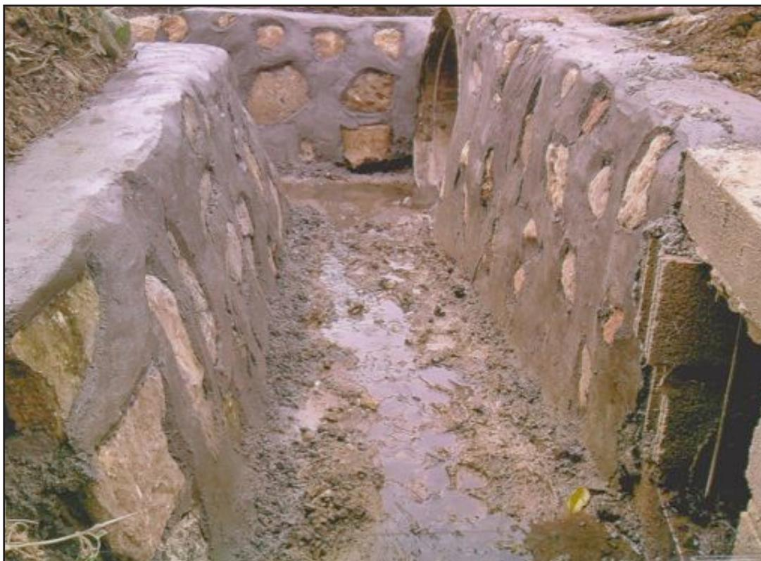
proteger el casco urbano de Arenoso de las subidas del río Yuna. El muro está revestido de piedra y tiene su centro de arcilla, que es un material cuya mina está en el mismo Arenoso, es decir que se utilizaron materiales de construcción de naturaleza endógena. El muro cubre 400 metros de protección y su construcción requirió del trabajo de 5 a 8 hombres por día que con carretillas transportaban los materiales por las entradas disponibles para acceder al frente del río.
