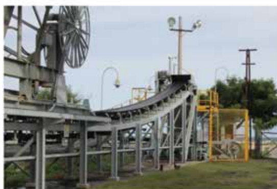
Instalaciones del muelle 6
