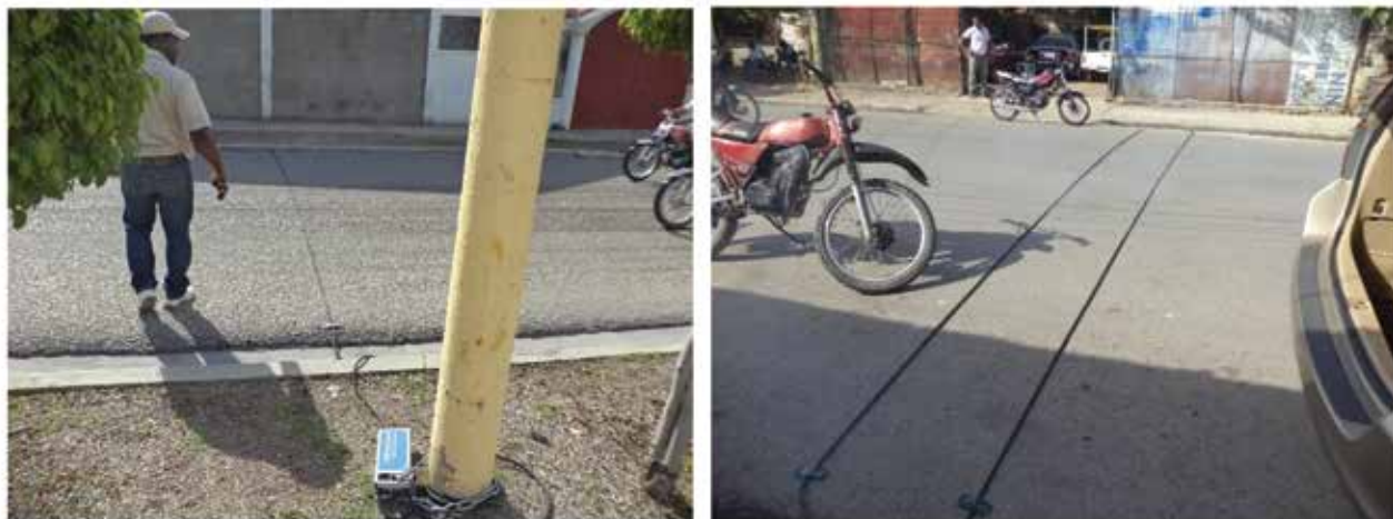
Figura 16. Instalación de Contadores Neumáticos en Estaciones de Conteo Mecánico
