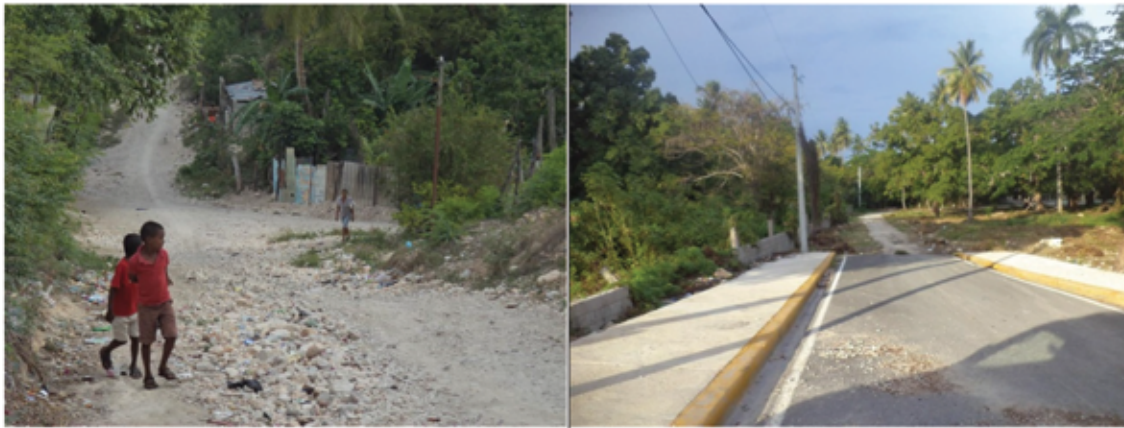
Figura 23. Vías No Pavimentadas en Barahona
