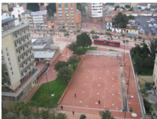
Plazoleta Calle 18 con Calle 3
