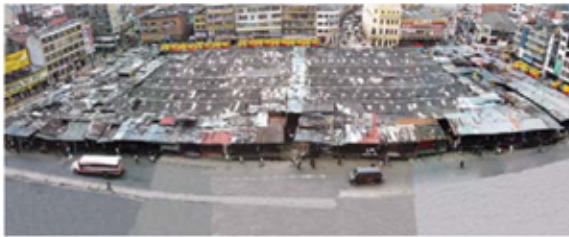
Antes de la intervención
